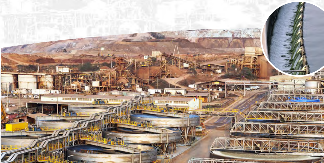
Sepon矿区污水处理现场
