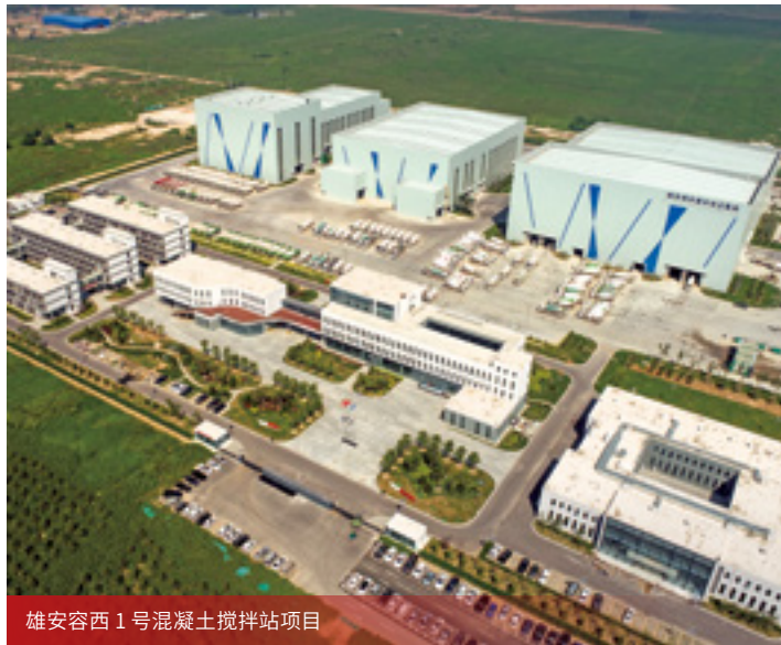
雄安容西1号混凝土搅拌站项目
