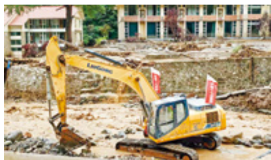
在榆中县 S104 周边疏通河道
