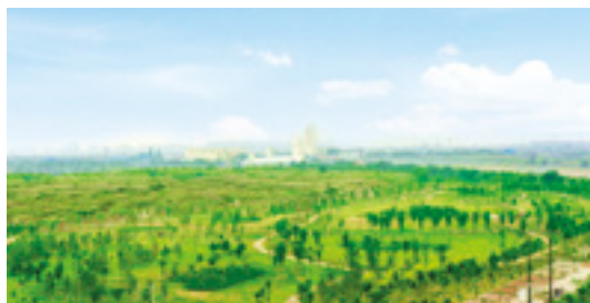
北洛河铁矿地质环境深度治理和绿化景观提升项目
