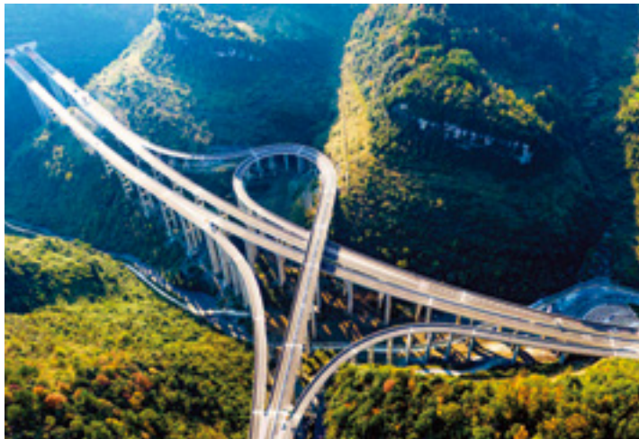
渝湘复线高速公路
