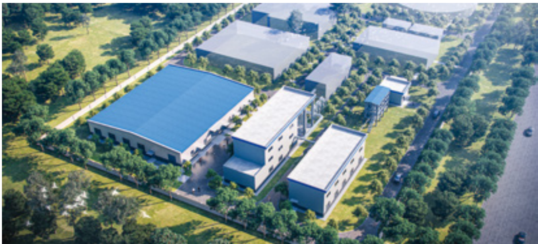
滁州污泥水热碳化示范项目鸟瞰图
