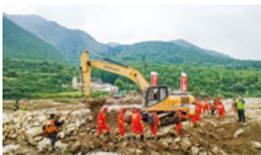
抢建通往杜家庄的临时便道
